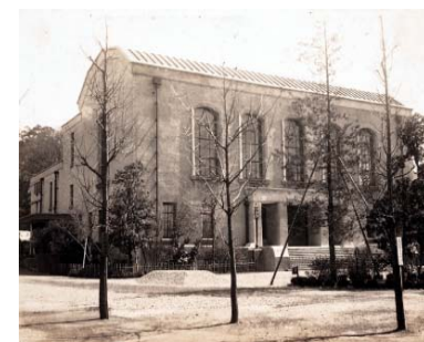
新図書館外観(現・2号館)
